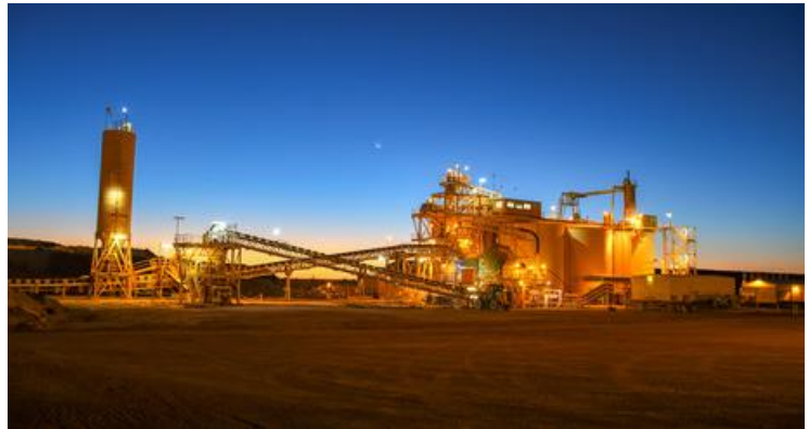
Photo : Comm System - Moolart Wells
